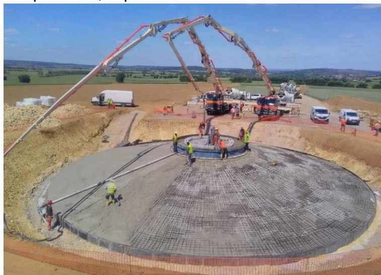
Crédit photo : Parc éolien du Nord-Sarthe – Base pour éolienne de 210 à 245 mètres en bout de pales
